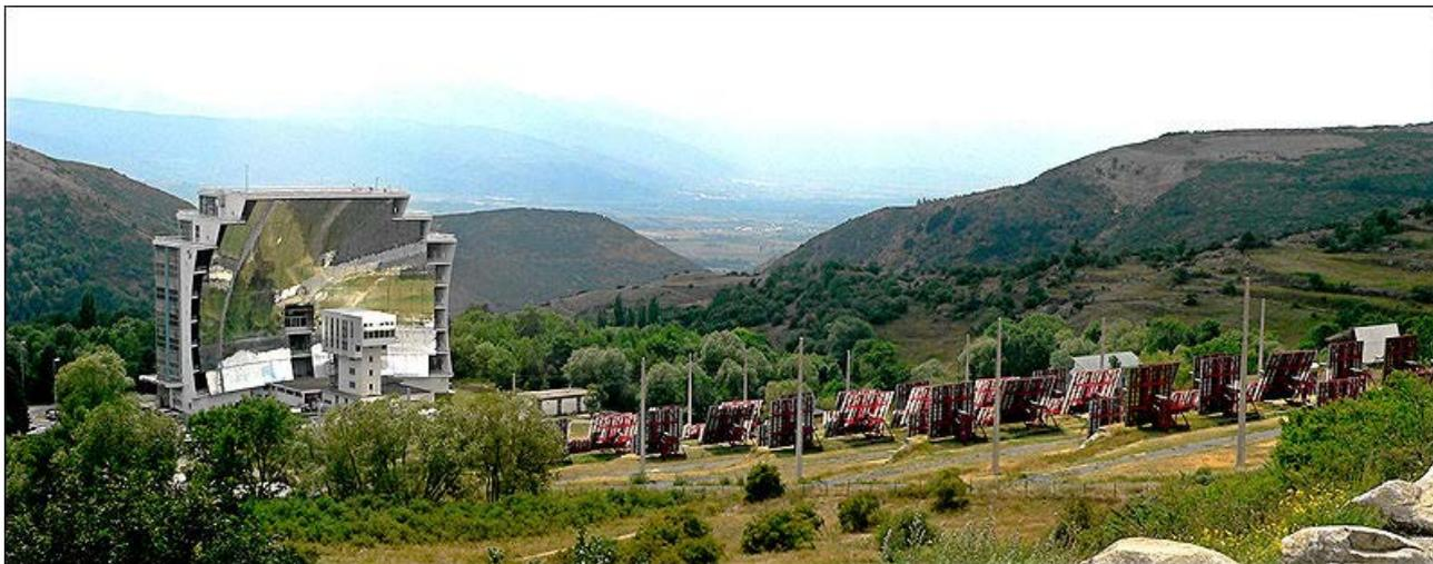
フランス国立太陽エネルギー研究所の超大型太陽炉。直径約 50m の凹面鏡型の反射板で焦点位置の温度は最大 3,000 度に達する。
